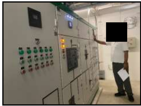
รูปที่ 2-20 มิเตอร์ไฟฟ้าสำหรับระบบบำบัดน้ำเสีย ของโครงการแยกจากระบบไฟฟ้าอื่นๆ
