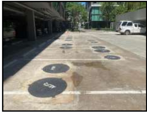
รูปที่ 2-10 ฝาลังระบบบำบัดน้ำเสียเป็นฝาลัง 2 ชั้น Double Seal
