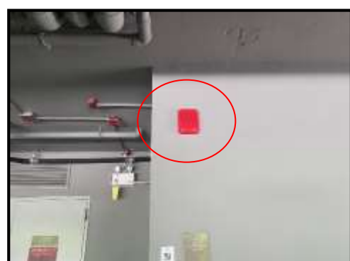
รูปที่ 2-40 เครื่องแจ้งเหตุด้วยเสียง
