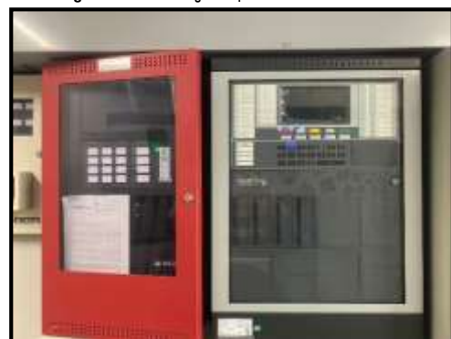
รูปที่ 2-38 แผงควบคุมระบบเตือนอัคคีภัย
