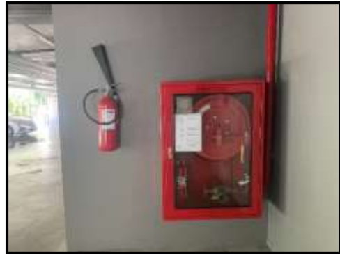
รูปที่ 2-36 ตู้ใส่อุปกรณ์ดับเพลิง
