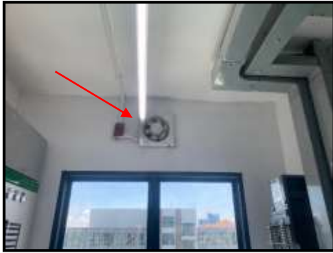
รูปที่ 2-33 เครื่องดูดอากาศบริเวณห้องพักรวม
